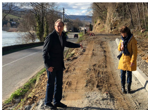
> M. le Maire et M me Maury, conseillère technique, sur les travaux du cheminement de Palétès
