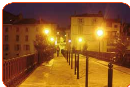
Le Pont-Vieux rénové.
